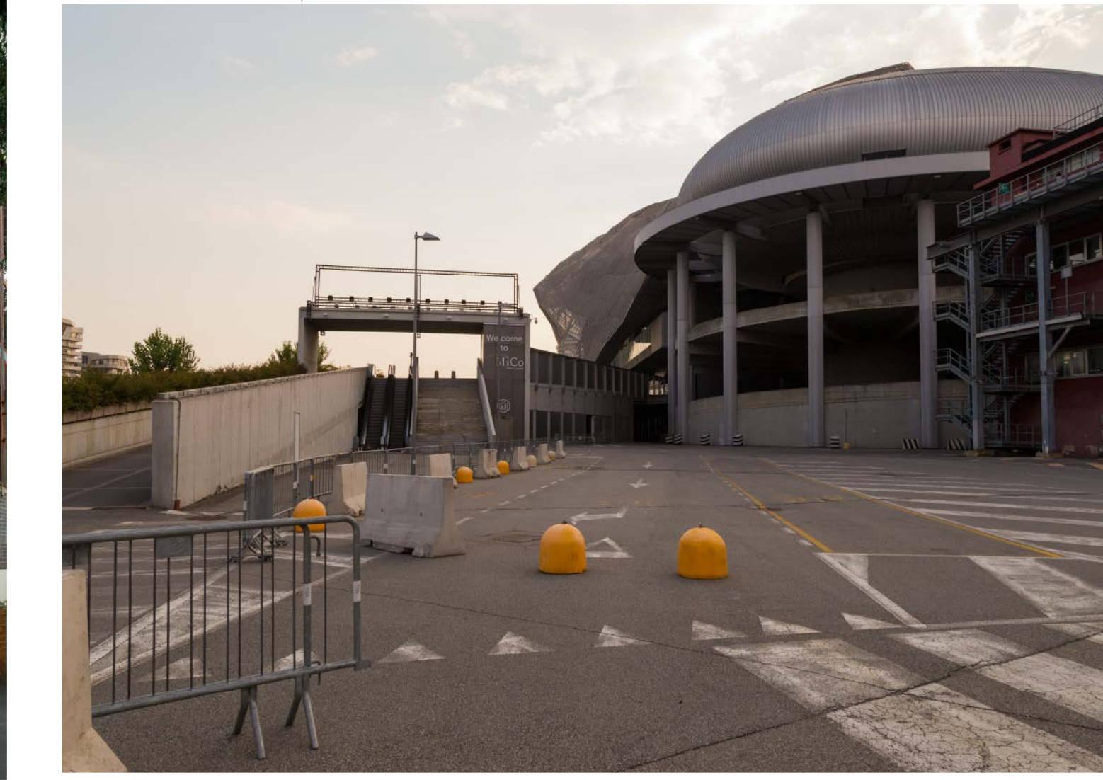
5 - Piazzale di manovra dei camion
